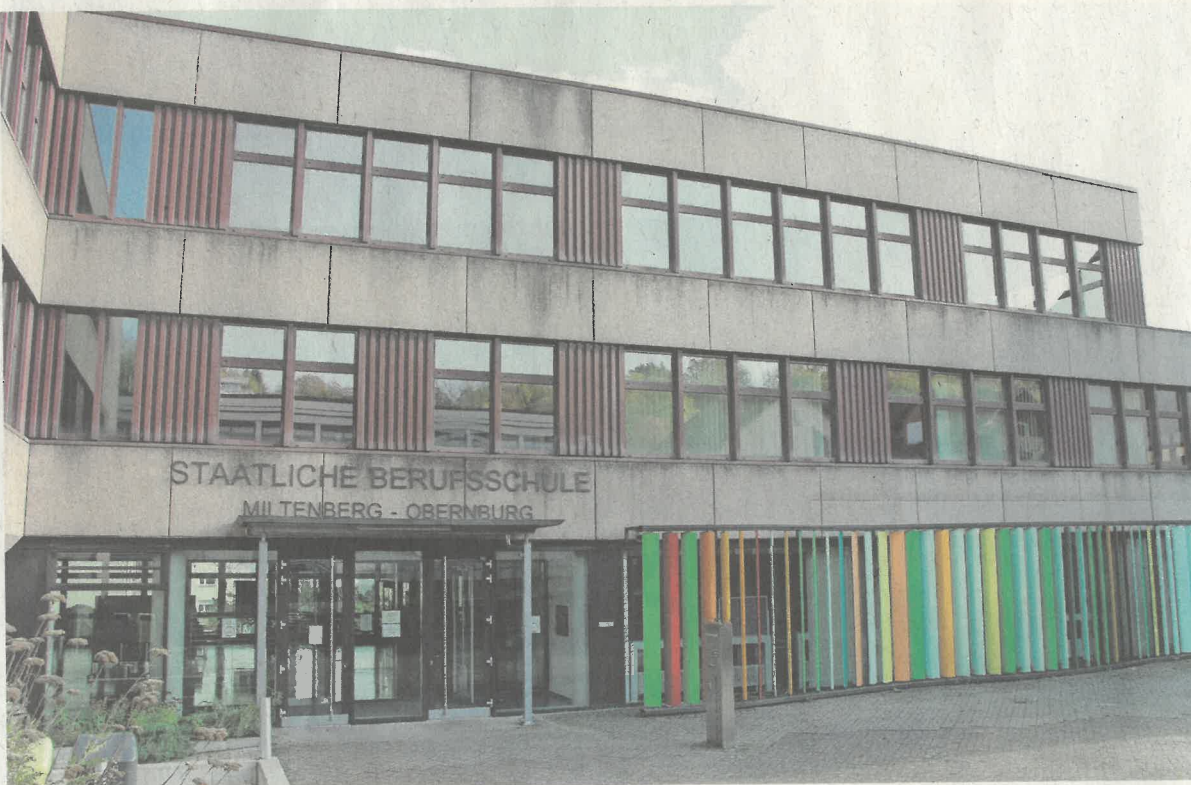
Die Staatliche Berufsschule am Standort Obernburg wird heuer 76 Jahre alt. Wegen Corona konnte das 75-jährige Jubiläum im letzten Jahr in Obernburg nicht gefeiert werden. Geplant ist hier eine Generalsanierung. Foto: Martin Roos
